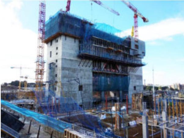
Les filets de type V sont un système constitué d'un filet avec une corde périphérique attachée aux bossoirs et à la potence au moyen de cordes d'attache. La chute de personnes et d'objets est limitée à partir d'une hauteur maximale autorisée de 6 mètres et d'une hauteur recommandée de 3.
