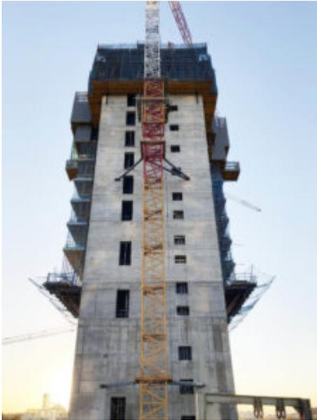
Ils ont également utilisé notre système de **filet de sécurité de type T**, un système pour empêcher les personnes et les objets de tomber. Ce système se compose d'une structure de type plateau qui supporte un filet de sécurité pour une utilisation horizontale.
